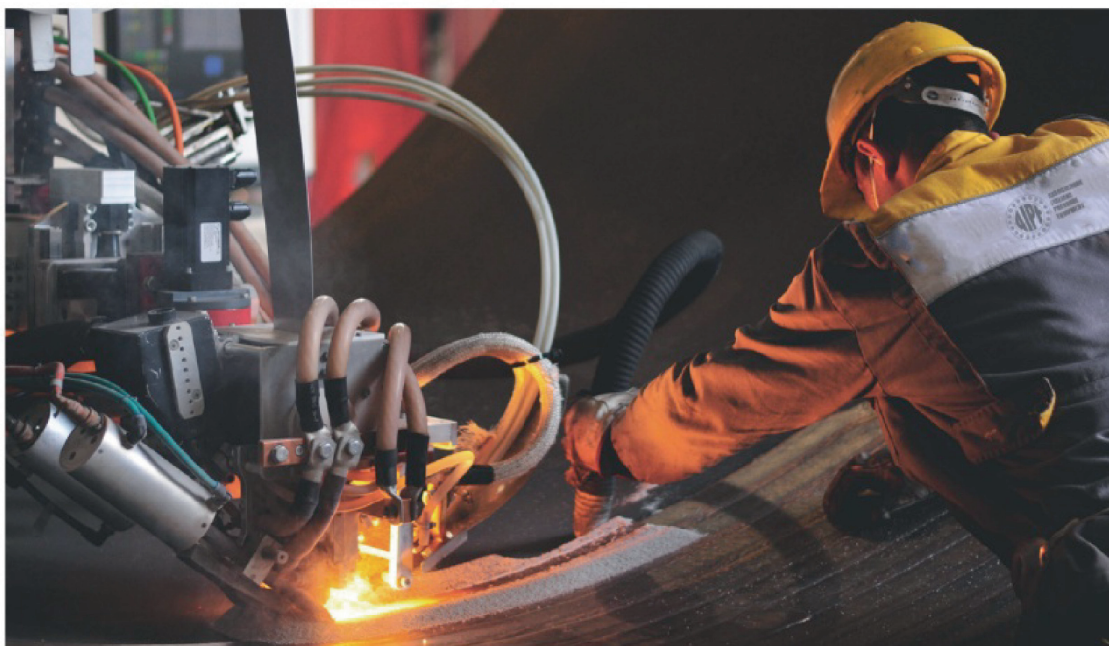
ESECUZIONE DI UNA PLACCATURA INDUSTRIALE
